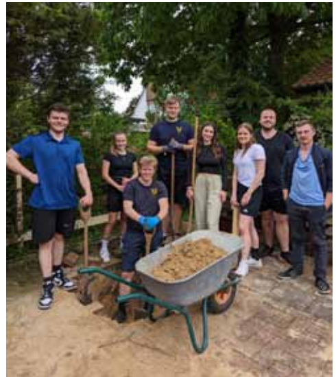
Auch zahlreiche junge Leute beteiligten sich am 17. Mai am ersten Arbeitseinsatz für den Pavillonbau. Gemeinsam wurden die Fundamente für die Pfosten ausgehoben.
