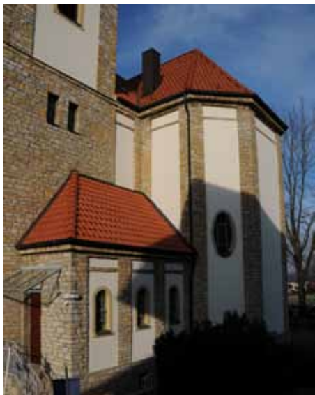
Der Fassadenanstrich wurde teilweise erneuert
