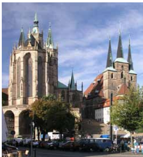
Ansicht des Erfurter Domes (links) und der Severikirche von Osten
